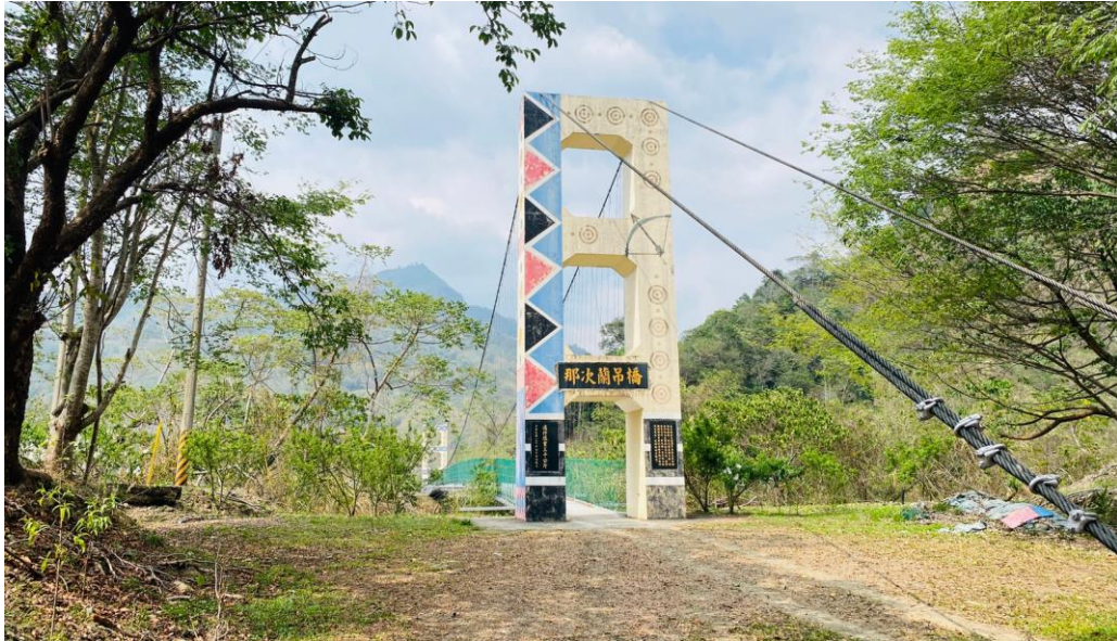
圖 29 那次蘭吊橋吊橋(20230522)
