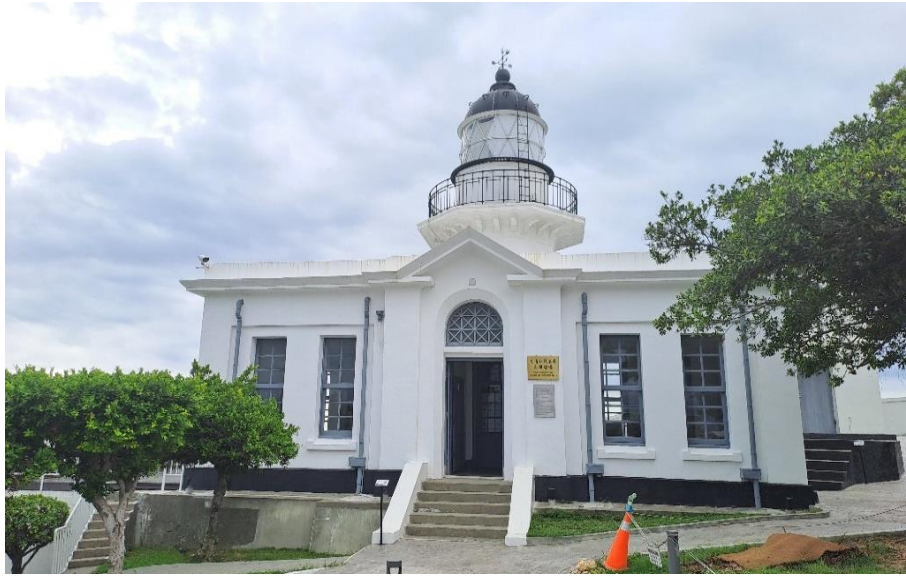
圖 11 高雄燈塔位於高雄港北口碑後方的旗後山頂/攝於 2023/07/20
